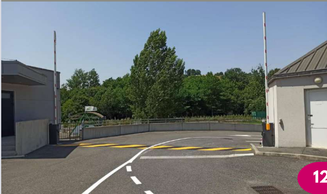
Déchetterie de St Côme
