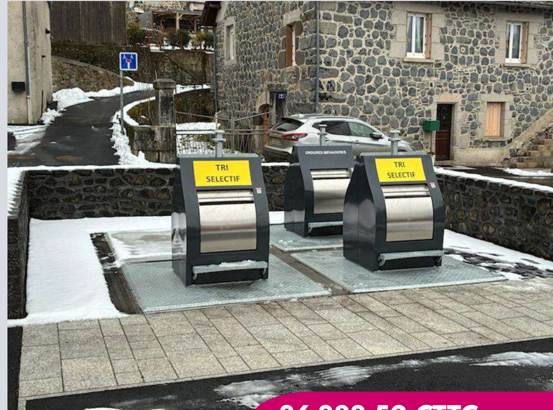
Installation des colonnes enterrées Place du Toural à Laguiole
